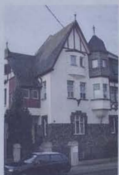
Das neue Dialysezentrum in Adenau in der Hauptstraße 16.
